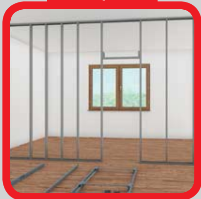
Připravená konstrukce SDK pro usazení zárubně
