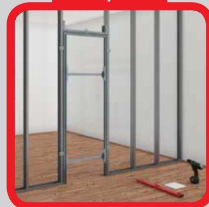
Zárubeň vložte do stavebního otvoru
