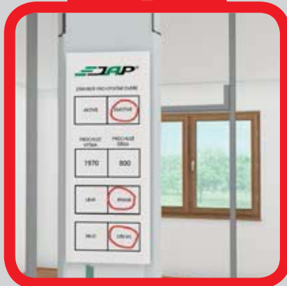
Zkontrolujte dodaný typ a rozměr
