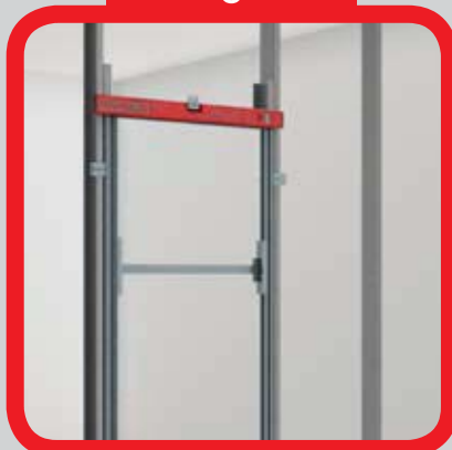
Vyvažte zárubeň horizontálně
